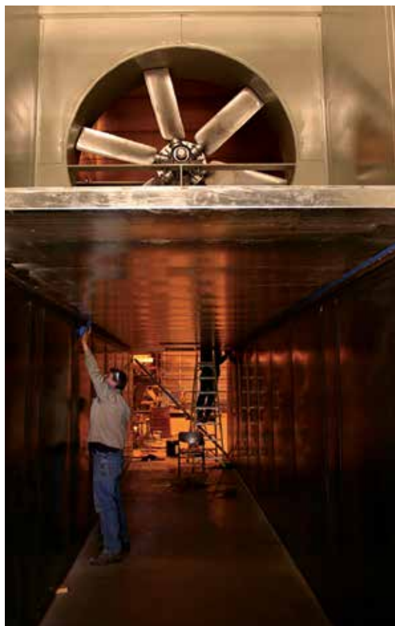
Arriba, los ventiladores de 20 HP de The Santiam se instalan en Slow Rapids, Missouri.
